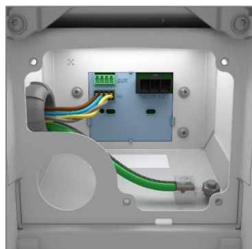
Schließen Sie die Kommunikationskabel in der Powerwall an
