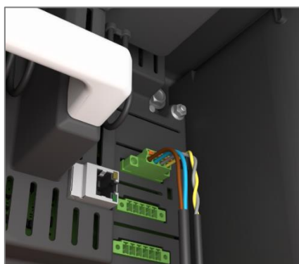
Schließen Sie die Kommunikationskabel im Backup Gateway an
