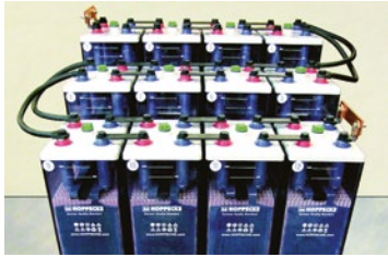
Abb. 5-16: Einsatz von Reihenverbindern und Stufenverbindern
