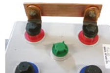
Abb. 5-18: 2 Montage der Endpole (Anschlussplatten)
