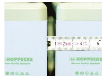
Abb. 5-14: 10 mm Abstand zwischen den Batteriezellen
