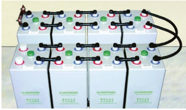
Abb. 5-15: Einsatz von Reihenverbindern und Stufenverbindern
